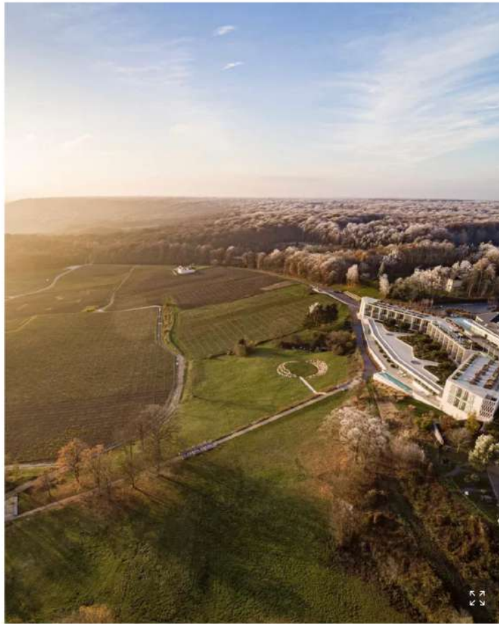
La bâtisse d'origine a bel et bien été rénovée mais c'est derrière l'enceinte que se passe le spectacle :
